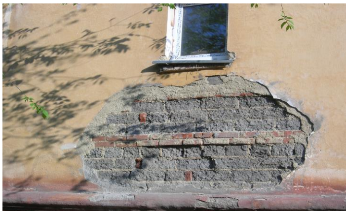
Рис. 3. Разрушение каменной кладки наружной стены здания на глубину до 20 мм в месте расположения ванной комнаты
