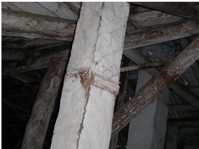
Рис. 7. Разрушение вентиляционных каналов
