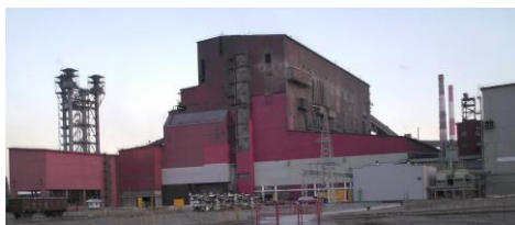
Рис. 1. Здание кислородно-конверторного цеха ОАО «ММК»
