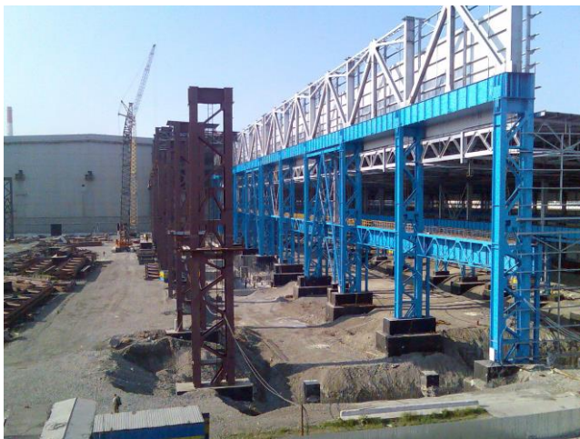
Рис. 7. Площадка строительства здания машины непрерывного литья заготовок ОАО «ММК»
