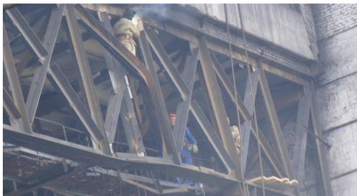
Рис. 5. Работы по замене раскоса
