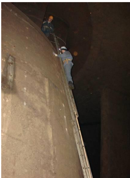
Рис. 9. Сквозное прозвучивание при контроле сплошности композитной системы: металлическая камера рабочего колеса турбины гидроагрегата – штрабной бетон заливки шахты камеры – монолитный бетон опорного конуса (вид со стороны опорного конуса)
